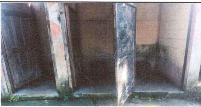
Foto 5: Letrinas a sustituir.
